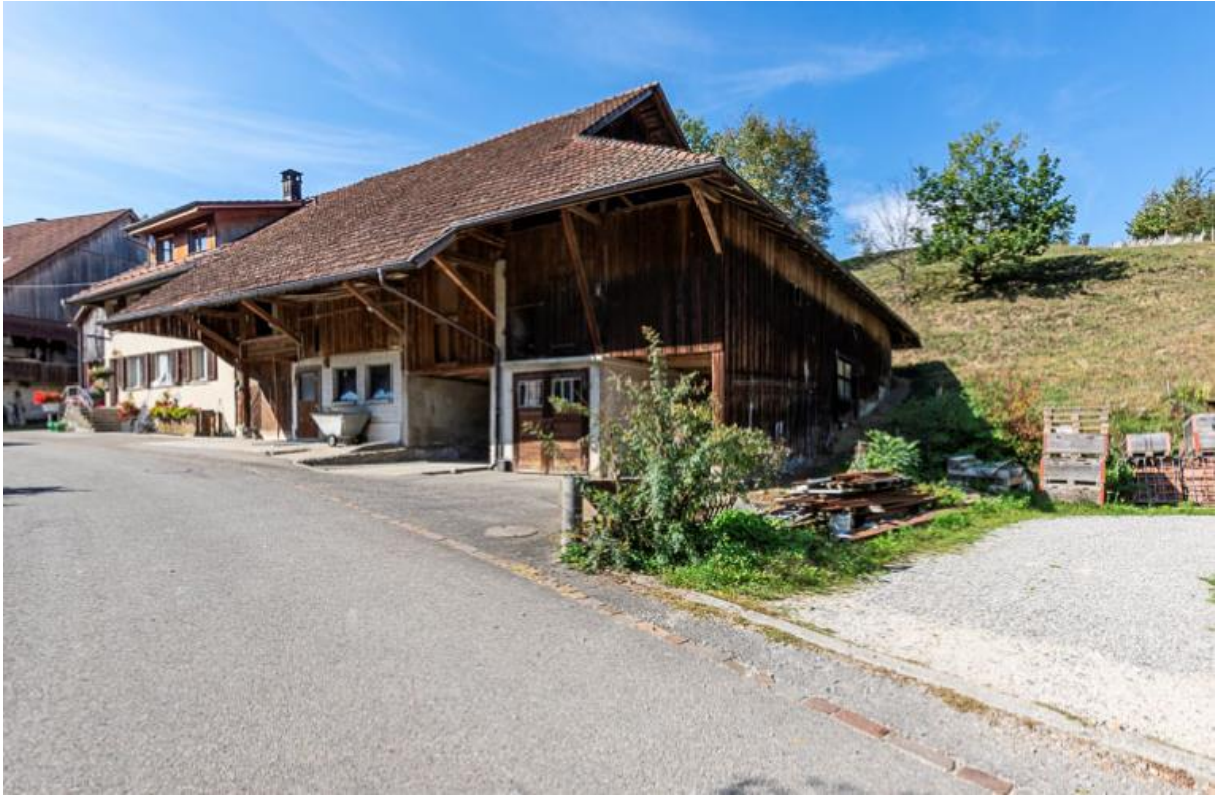
Südostansicht Scheune und Wiesland
