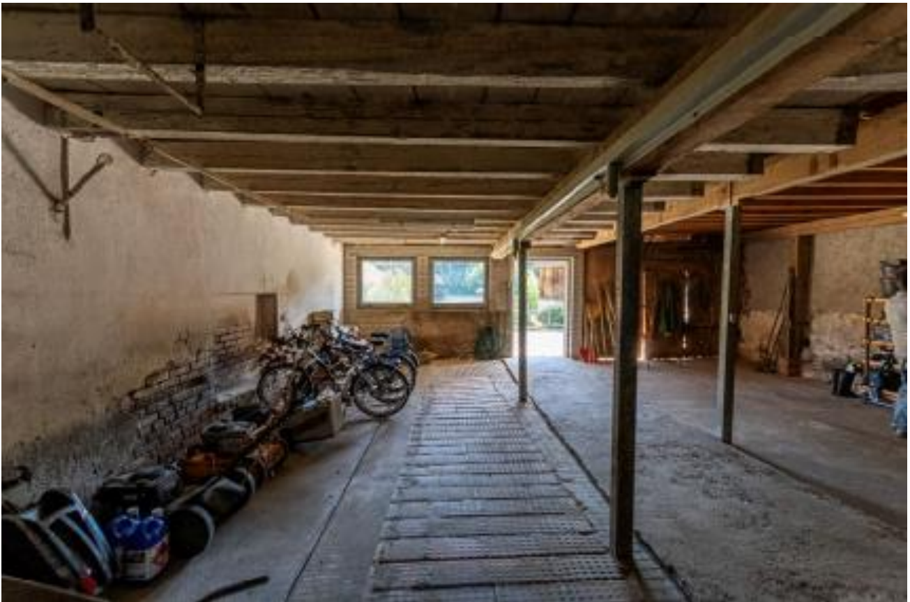
Ehemaliger Stall in Scheune Nr. 230
