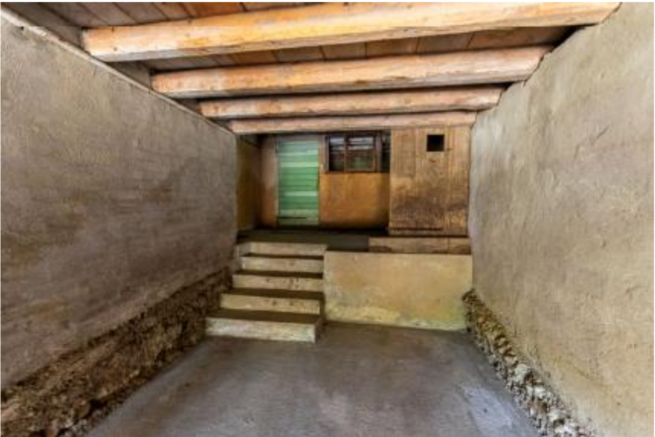
Lagerraum in Scheune Nr. 230
