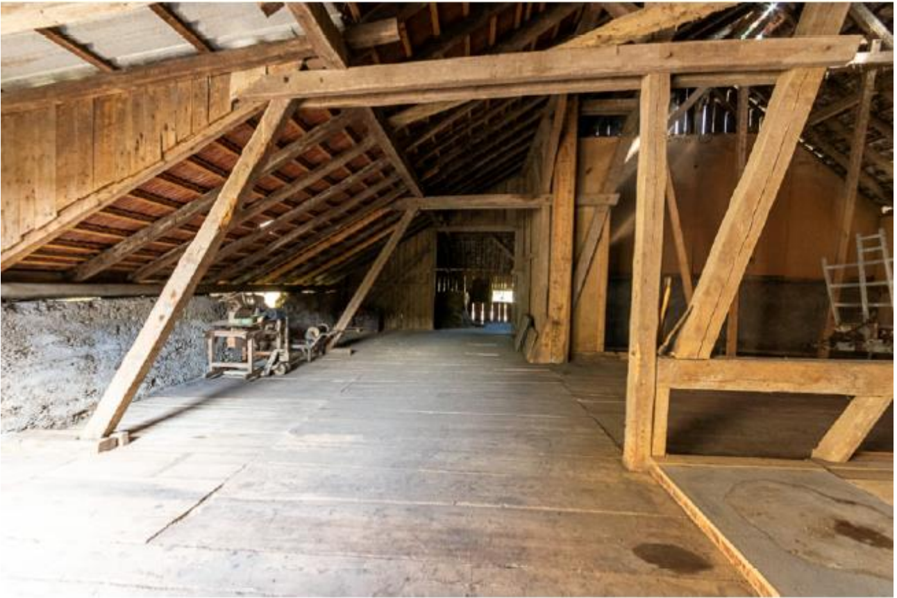
Einfahrt OG Scheune Nr. 230 neben Wohnhaus
